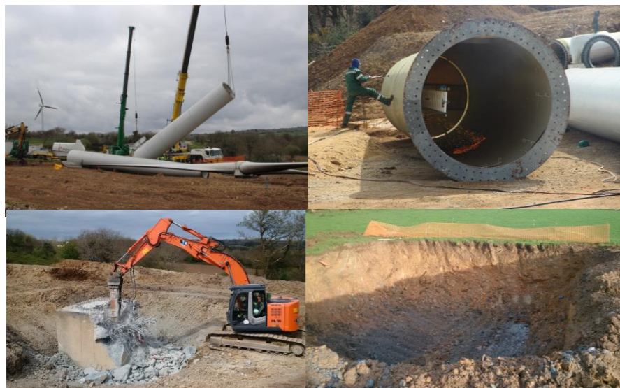
Photo : Démontage et découpage des fûts avant recyclage (Plouyé 29)
